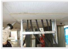
동일한 방법에 의한 이면 시공
